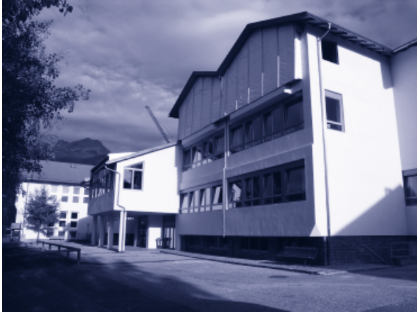
Hier werden Nägel mit Köpfen geschlagen: Umbauarbeiten an der Grundschule Latzfons. Nuove esigenze subito riconosciute: lavori di ristrutturazione presso la scuola elementare di Latzfons
